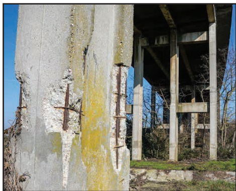
Il degrado delle pile
